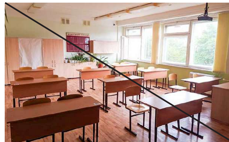
Плохо Линолеум под дерево
